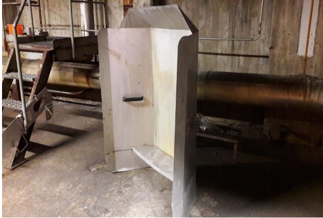
Skyddssköld som instrument använder när dom spettar upp bubbelrören (nivåvisning lösare)
