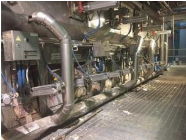
2016-11 Obbola SP2, Smältagenombrott genom primärluftkanaler och ner på golvet
