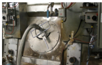
Vatten in via brännaröppning
