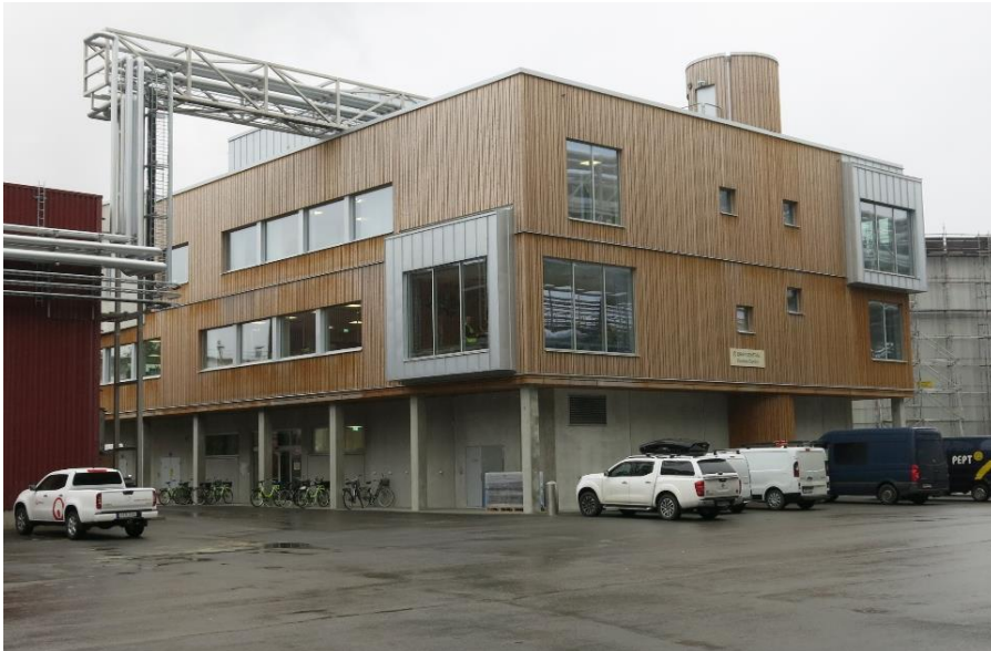
Figur 3-3 Det nya kontrollrummet.
