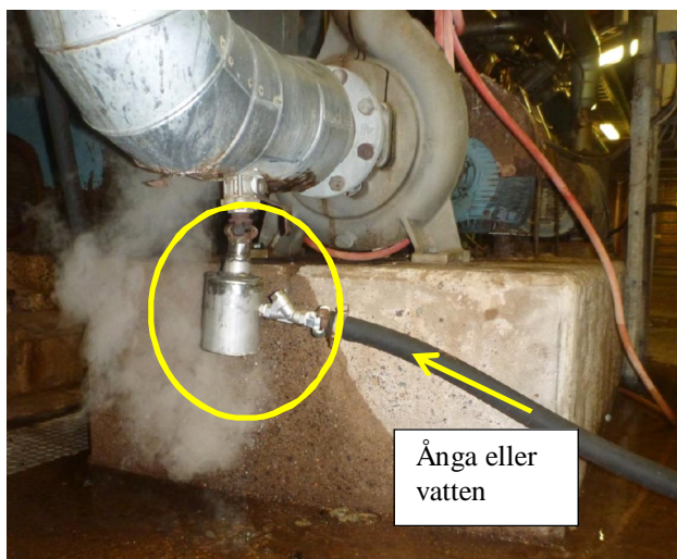
En spolapparat fästs till den ledning där det finns ett stopp. Uppspolningsmedium ånga eller vatten
