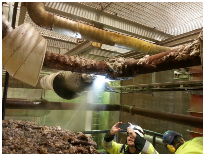
Under drift upptäcktes ett läckage på ett T-stycke på matarvattenledningen
